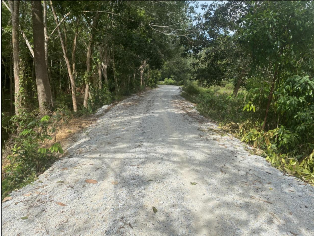
๓. โครงการปรับปรุงถนนหินคลุก สายบ้านลูโบะตาโต๊ะ - อ่างเก็บน้ำ
