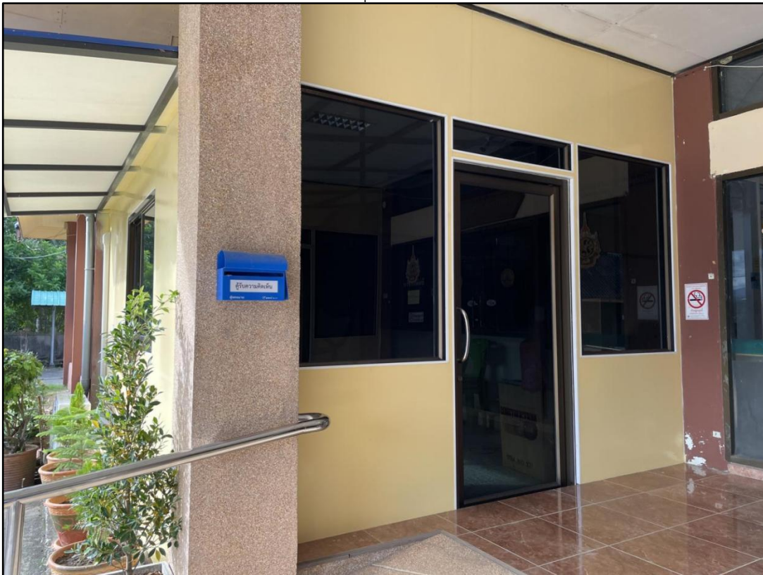
๔. โครงการปรับปรุงต่อเติมอาคารสำนักงาน
