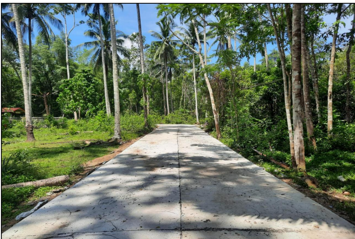
๖.โครงการก่อสร้างถนนคอนกรีตเสริมเหล็ก ซอยกุโบร์ฮูแตจี้จิง
